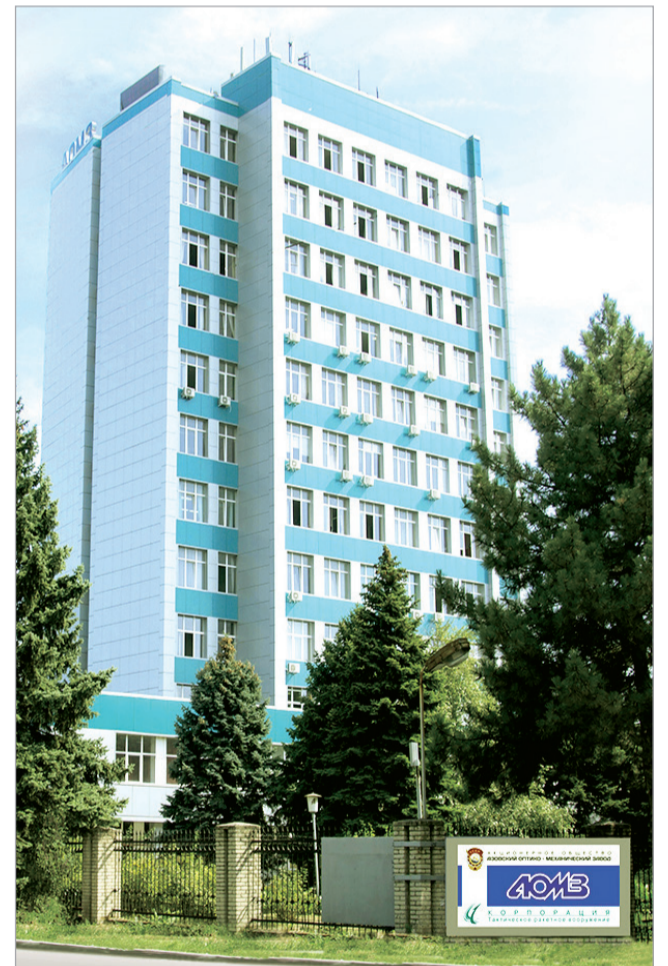
▶▶ Административный корпус после реконструкции
