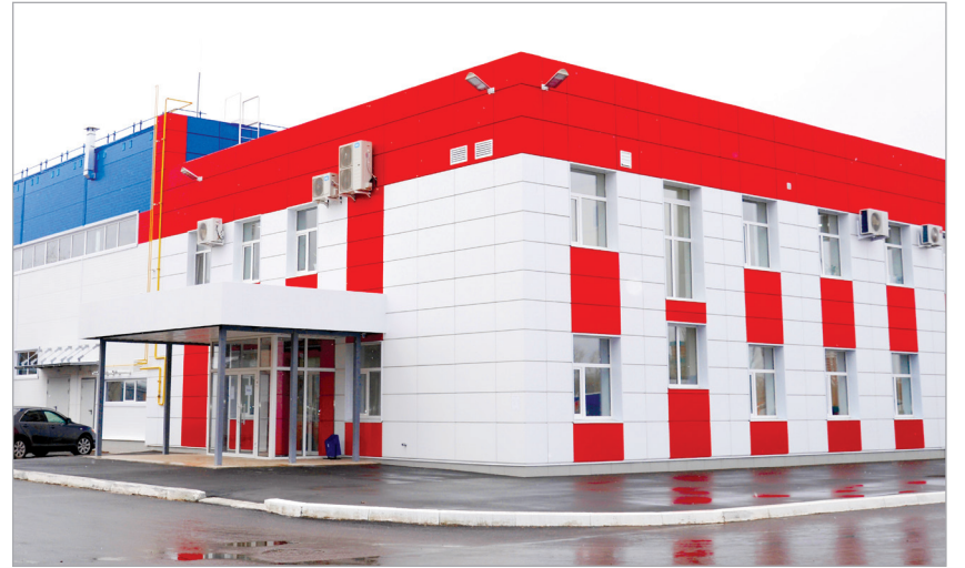
Здание нового автотранспортного цеха
